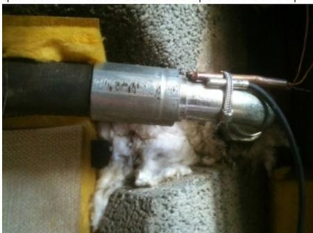
poi l'acqua arriva ai 2 termoconvettori collegati in parallelo avendo i radiatori all'interno i raccordi da 1/2" e il tubo del camino da 1"
